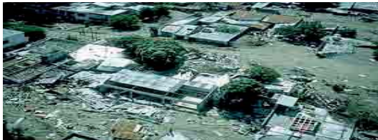
Solo unas pocas estructuras se mantuvieron en pie en Armero tras las corrientes de lodo que arrasaron con el pueblo.
